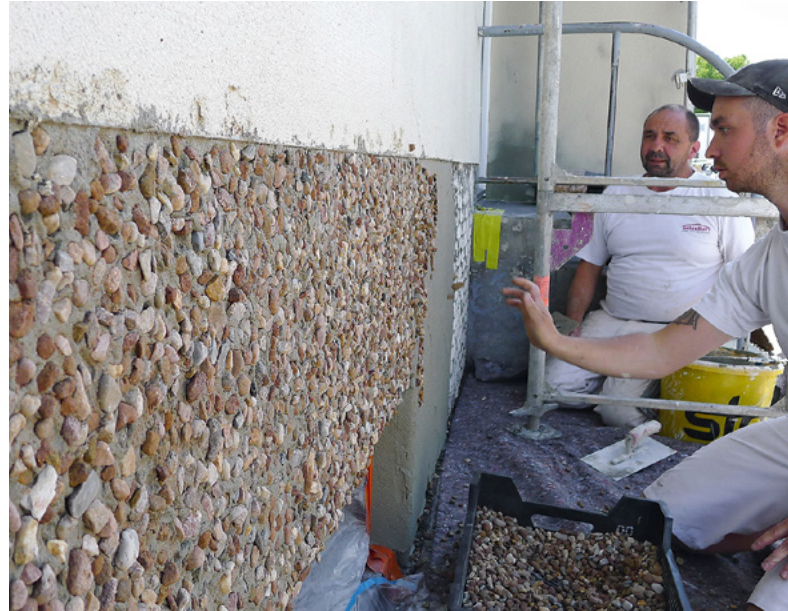
Pebble dashing: Bewurf des frischen Putzes mit Kieselsteinchen (Foto: Elmar Lixenfeld)
