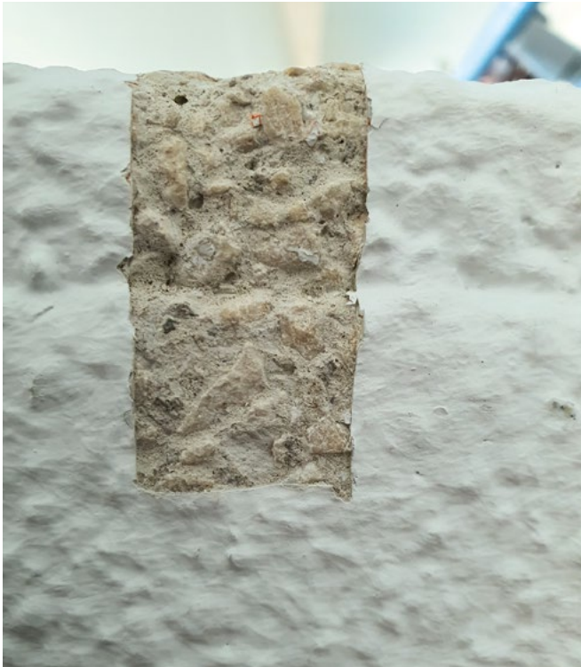
Freigelegtes Detail der Emporenbrüstung: Unter den weißen Farbschichten liegt die bauzeitliche Edelputzoberfläche. Bei diesen ursprünglich ungefassten Oberflächen wurden Farbigekeit und Struktur durch die zugesetzten Splitt-Zuschläge erzielt. Grundfarbigkeit der Putze in der Schwimmhalle war ein heller warmer Kalksteinton, 2020 (Foto: Leonie Saltzmann-Tyll)
