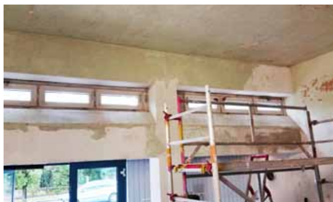
Renovierungsarbeiten und Demontage der abgehängten Decke (Foto: Peter Paul Schepp)
