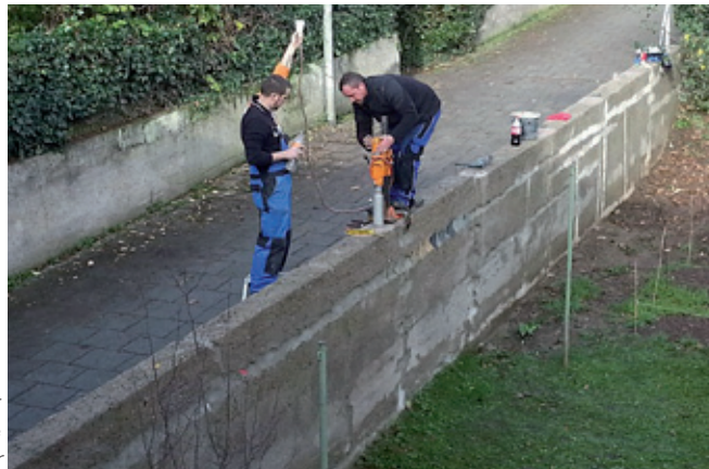
Metallbauer beim Montieren der Rankhilfe Foto: Juliane Geißler
