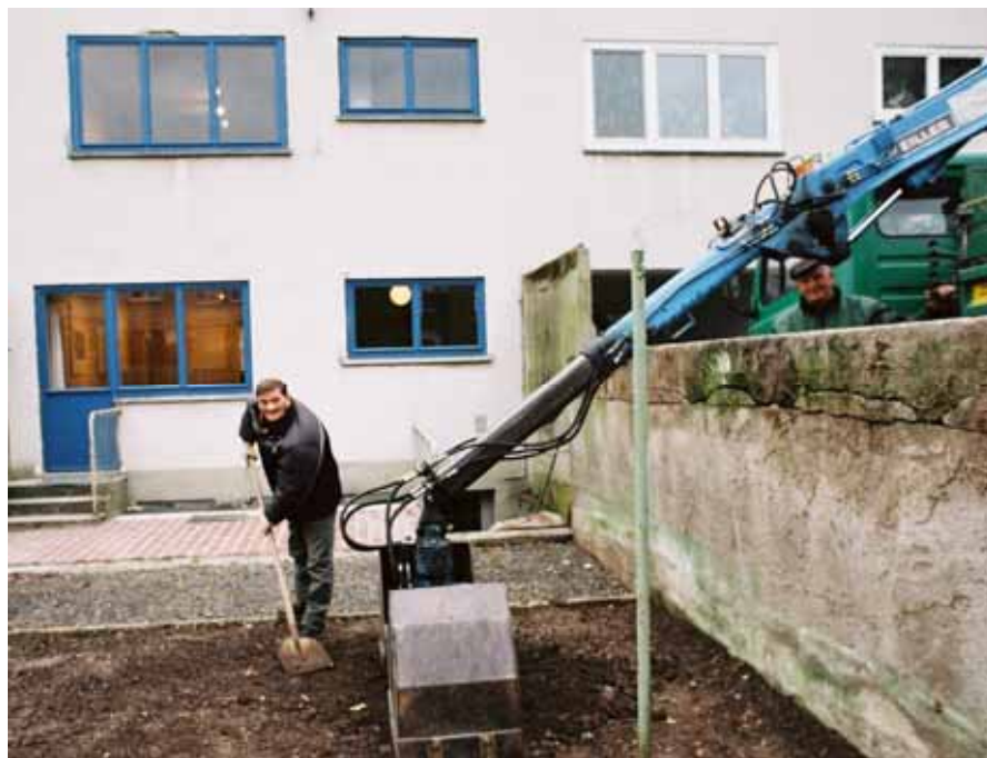
Erdarbeiten im Hausgarten des ernst-may-hauses
